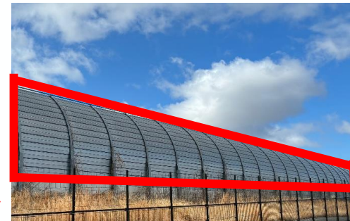
高速道路内の遮音壁（外壁）
