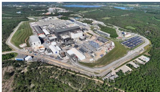
ITER(国際熱核融合実験炉)の建設状況(2025年5月) (南仏(サン・ポール・レ・デュランス)) 提供: The ITER Organization
