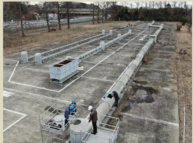
下水道管路模擬施設 全景
