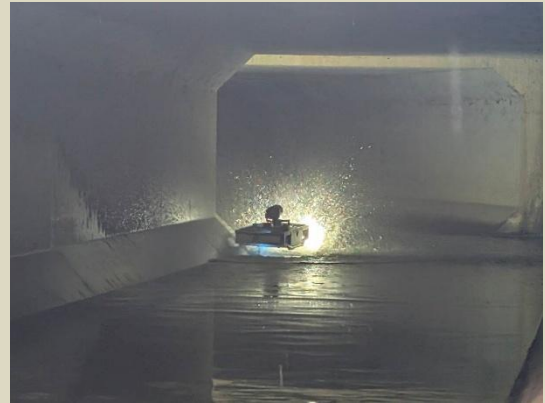
下水道管内を飛行するドローンの様子
